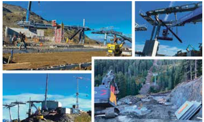
Die Firma Leitner hat bereits mit der Montage der Bergstation und der Seilbahntechnik begonnen. Die Inbetriebnahme ist für Mitte Dezember geplant. (Foto: Gemeinde Tulfes)
