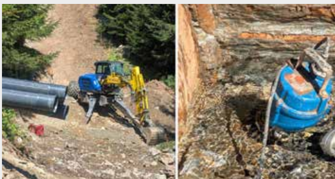
Die Bauarbeiten bei der Schranbachquelle schreiten positiv voran (Fotos: Josef Egger)
