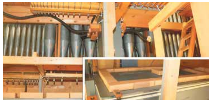
Beengtes Innenleben, die Luftbälge werden mit rund 200 kg Ziegelsteinen vorgespannt
